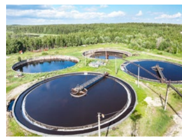
Residuos y agua
